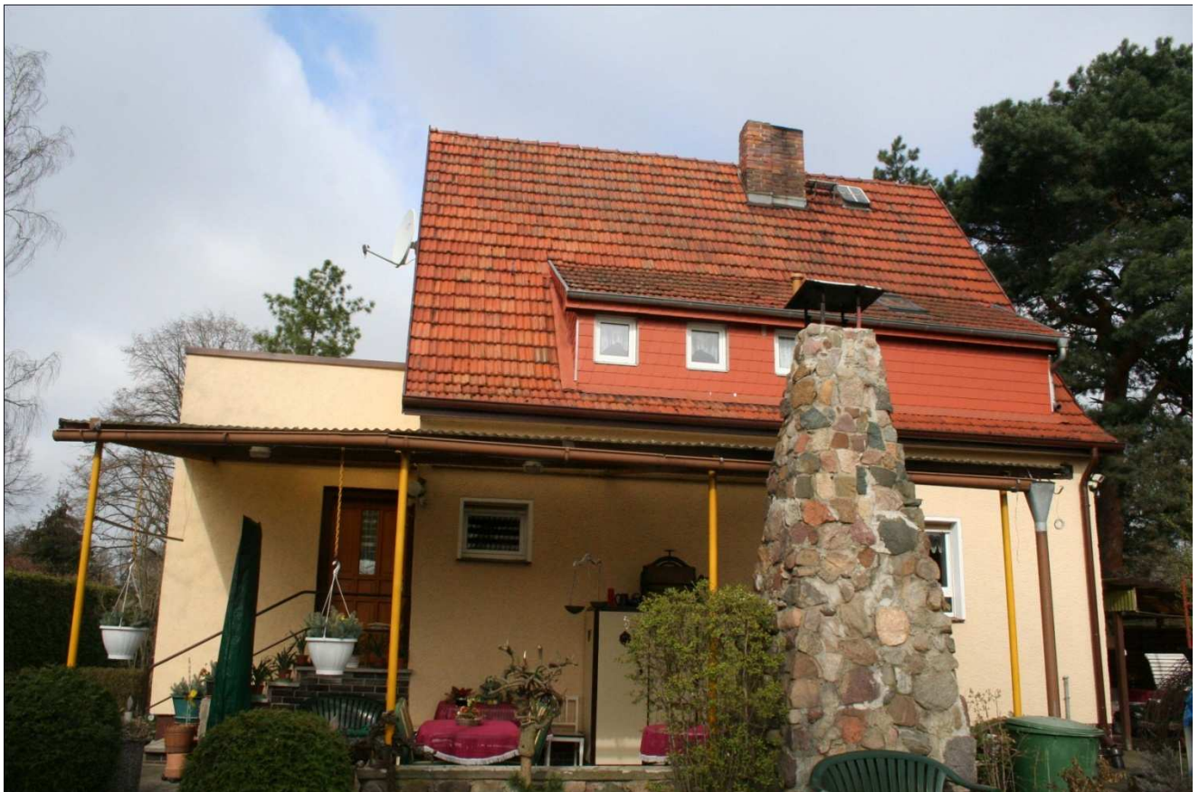
Rückseite mit Terrasse- überdacht und Außenkamin
